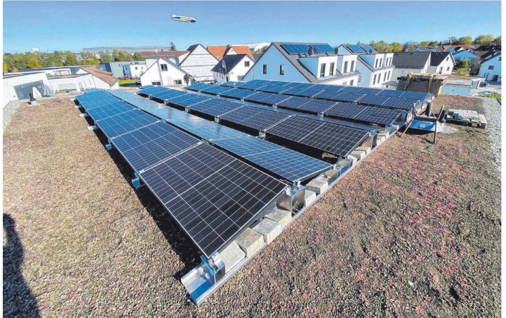
Wer hier arbeitet, muss schwindelfrei sein: Viele Solaranlagen auf den Dächern in der Region sind von der Firma Dehm montiert worden.
